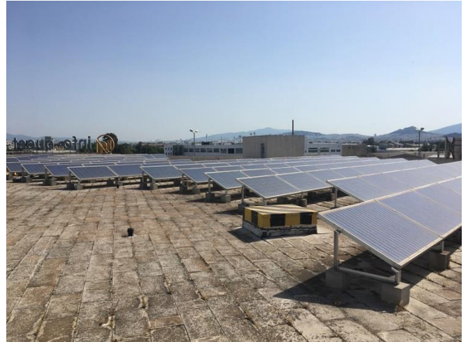
Άποψη εγκατάστασης φωτοβολταϊκών
