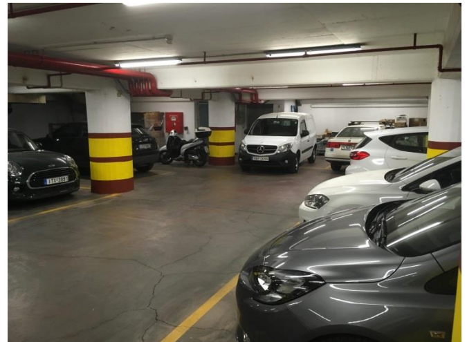
Θέσεις στάθμευσης υπογείου
